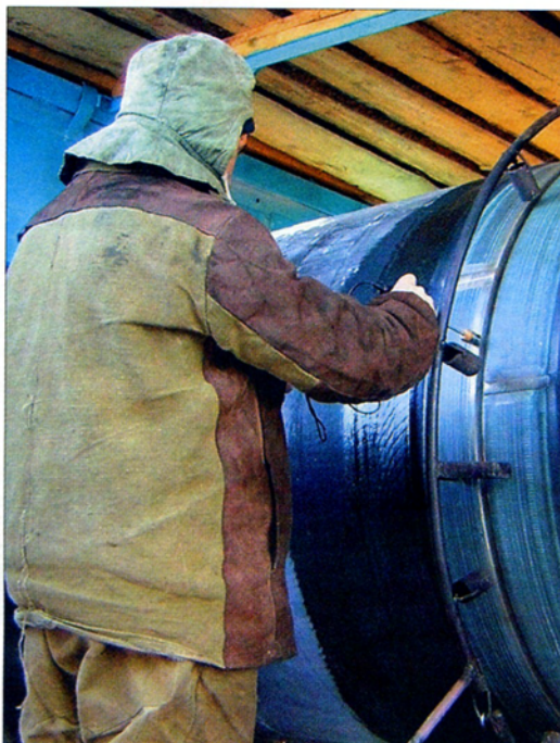
Проверка швов: сварщик несет персональную ответственность за качество
